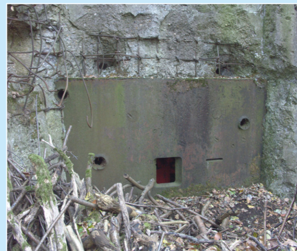
▲ Une protection trompeuse ! Cette plaque embrasée a été pénétrée en douceur par trois grenades de 76 mm.
