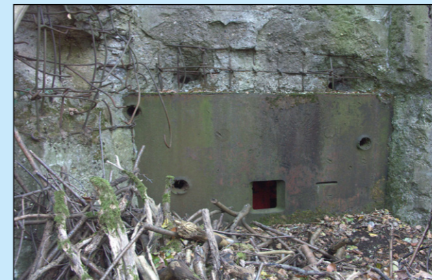
▲ Trois tirs d'un canon de 76 mm ont pénétré en douceur dans le panneau embrasé en acier laminé doux.
