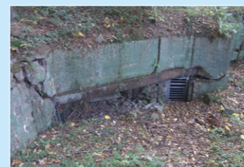
◀ Un bunker dynamité dans la forêt de Hürtgen avec des portes en treillis métallique pour les chauves-souris.
