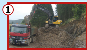
1 L'aménagement de chemins et sentiers d'exploitation.
