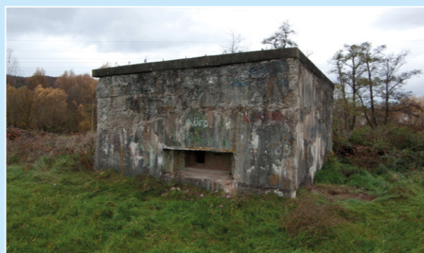
▲ Un Regelbau 1 avec plaque embrasée à Körprich en Sarre.
